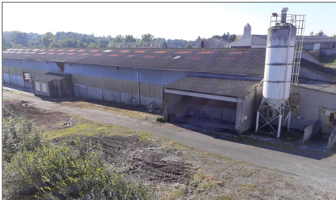
Photo n°2 : vue de la parcelle nouvellement rachetée sur laquelle les anciens locaux seront démolis
